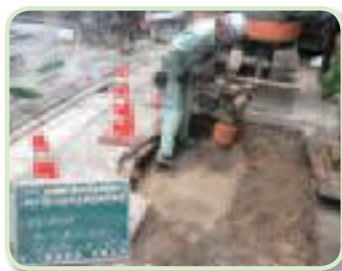
土木緊急修繕の様子
