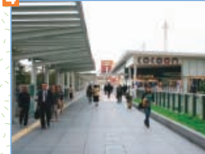
4 駅から連続する屋根(シェルター) 多少の雨をしのいで駅から施設まで移動できます。
