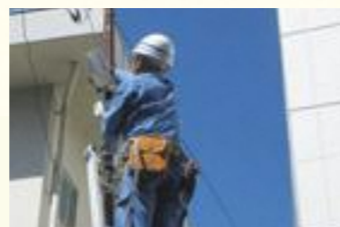
(施設修繕の様子)
