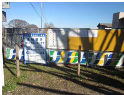
工事の様子（東縁）
