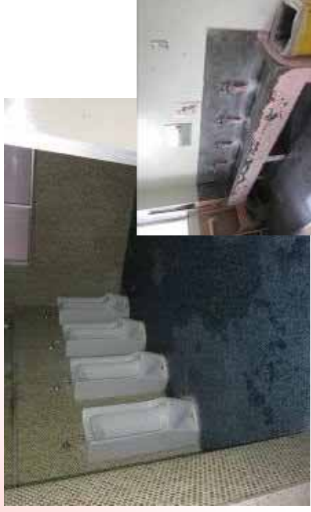
屋上防水の老朽化で 頻発する雨漏り
