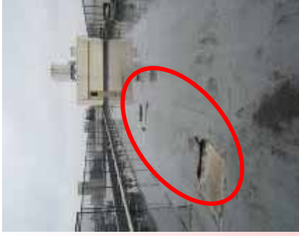
屋上防水の老朽化で 頻発する雨漏り
