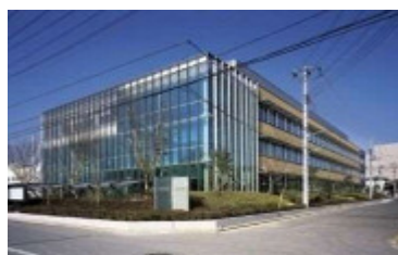
緑区役所庁舎
