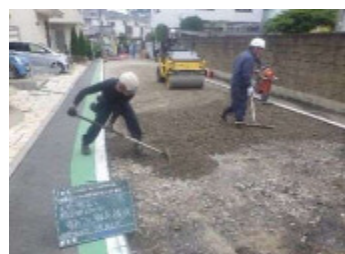
土木緊急修繕
