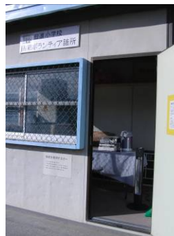
▲校庭の一部にあった倉庫を詰所に転用
